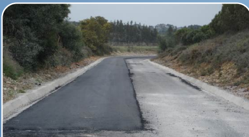
E. BARCA AO CM1124 - CM1058 - SANEAMENTO REPARAÇÃO E CAMADA DE DESGASTE
